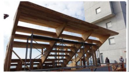
CLT Cafe CLT 大震動台実験部材のリユース
