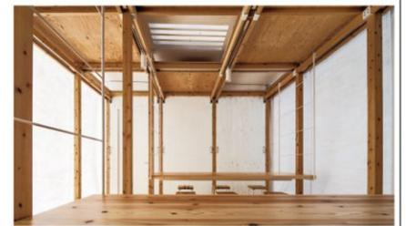
Timber75-1, 2 小径木(75mm角材)の組立て可能工法
